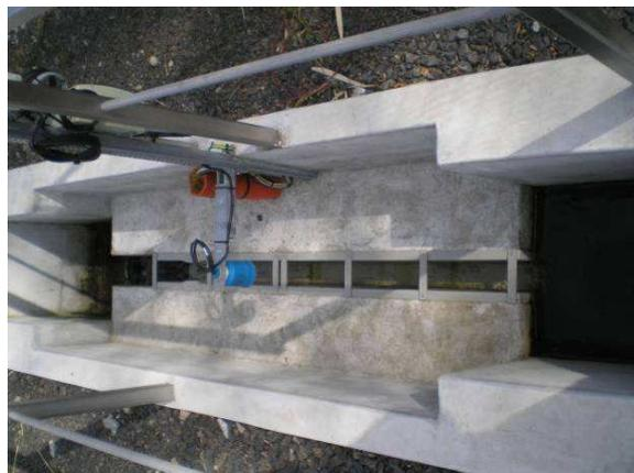
Canal de comptage équipé d'une mesure ultrason
